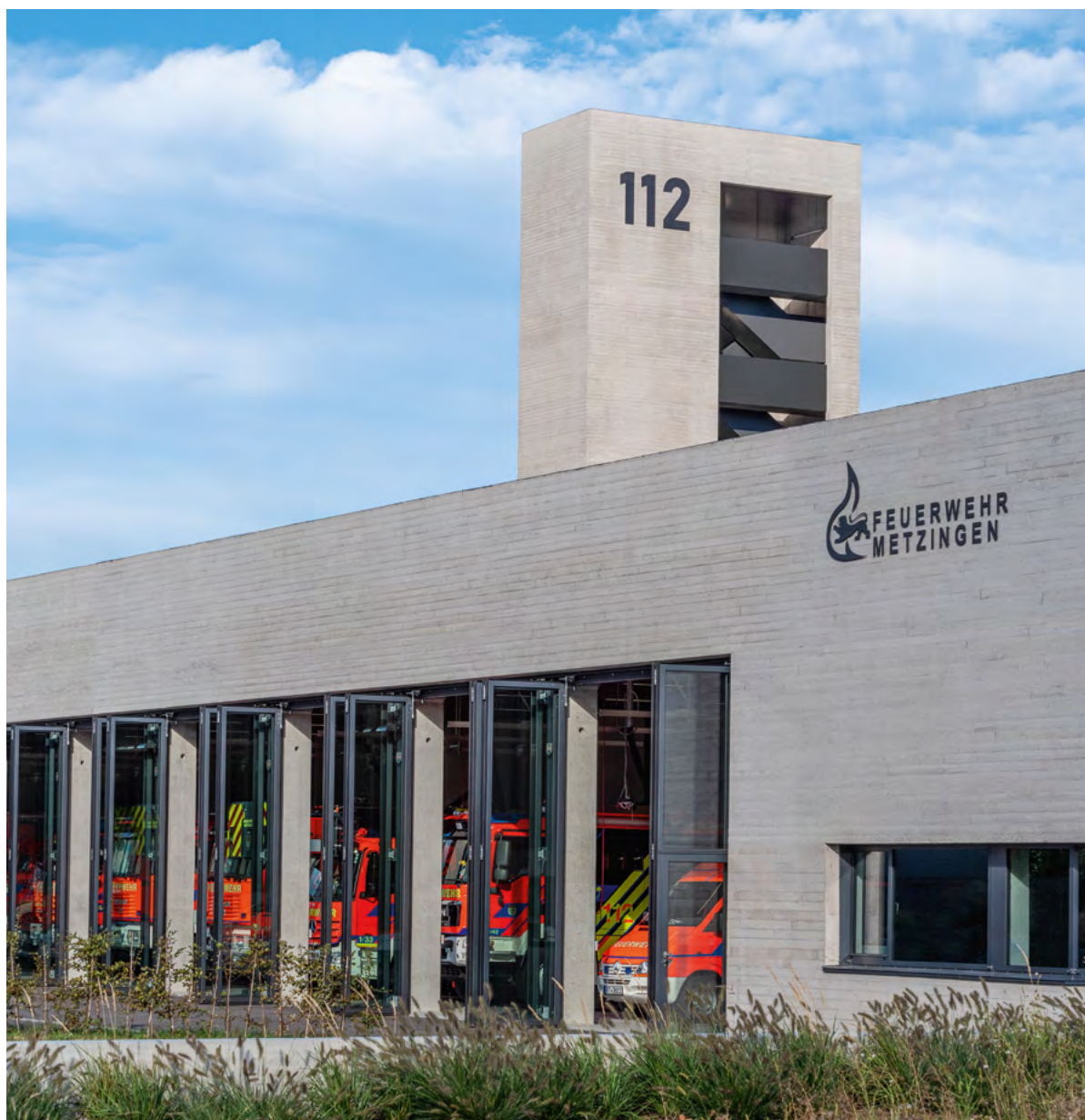
Feuerwache Metzingen: Der erforderliche Wärmeschutz gelingt durch den Einsatz von Leichtbeton.
