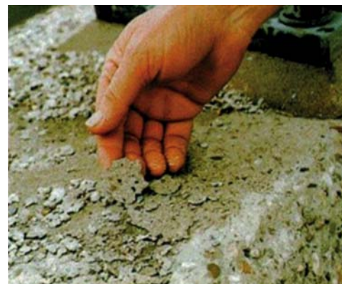
Abb. 2: Schadensbild eines Betons ohne ausreichendes Mikroporensystem nach Frost- und Taumittel-Beanspruchung
