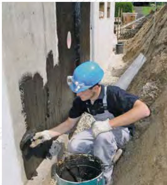
Auftrag einer Bitumendickbeschichtung
