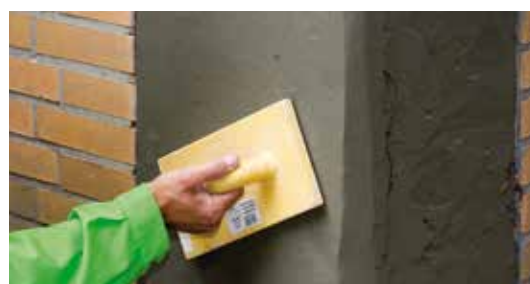
Reparaturmörtelauftrag
