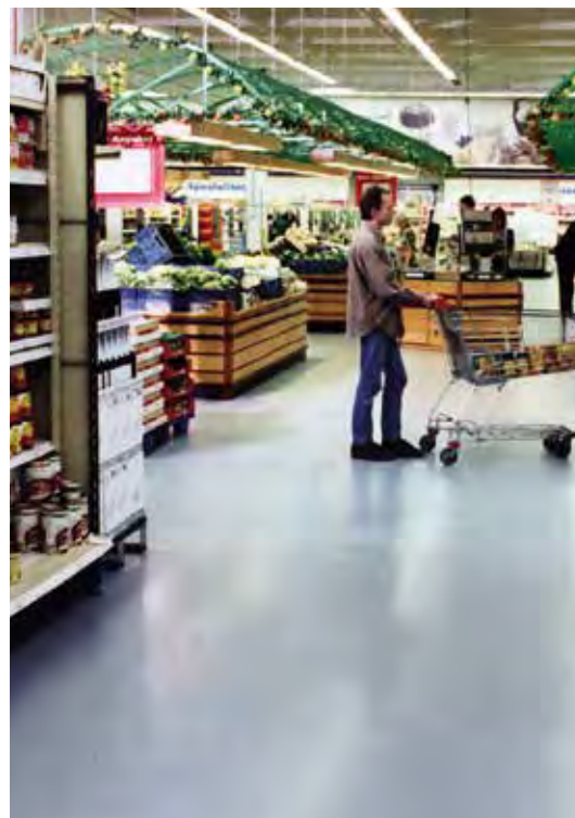
MMA-Bodenbeschichtung in einem Supermarkt
