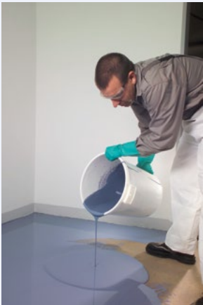
Ausgießen der farbigen Epoxidharz-Beschichtung
