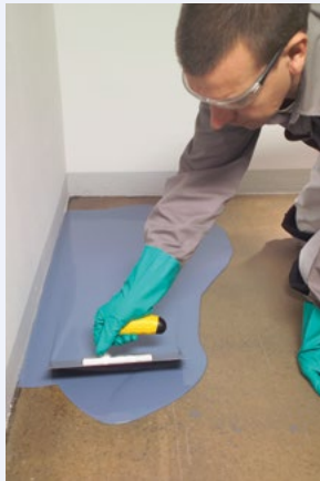
Kniendes Verteilen der Epoxidharz-Beschichtung im Eckbereich
