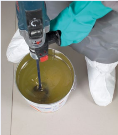
Anmischen einer Epoxidharzgrundierung mit langsam laufendem Rührwerk mit Spritzschutzschürze und Überziehschuhen
