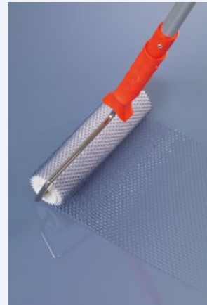
Entlüften der applizierten Beschichtung mit einer Stachelwalze im Kreuzgang
