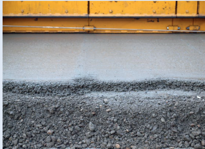
Ober- und Unterbeton
