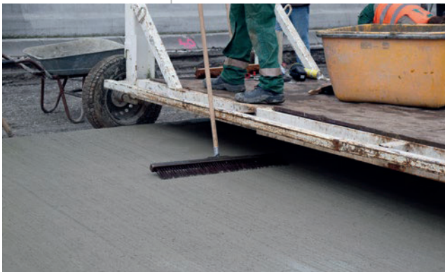
Einbau durch Fertiger
