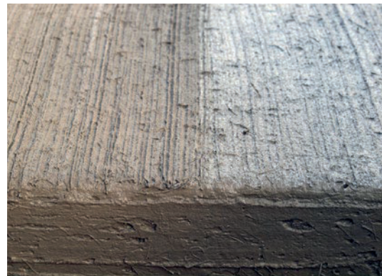
Fertige Polymerfaserbetonoberfläche mit Besenstrich; Dosiermenge 3,5 kg/m 3
