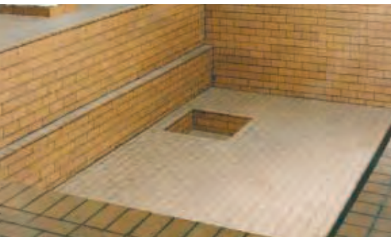
Abb. 14: Keramische Auskleidung einer Grube mit Sumpf
