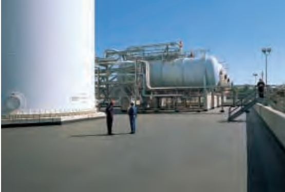
Abb. 8: Beschichtung einer Auffangtasse
