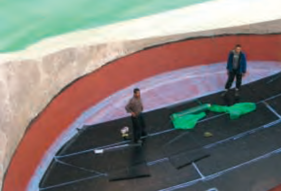
Abb. 18: Ausführung einer Gummierung in einem Betonbehälter
