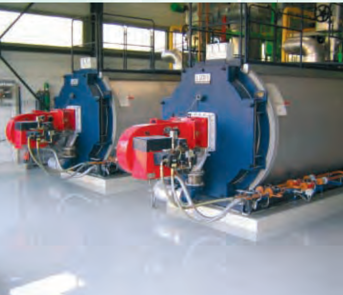
Abb. 17: Industriebeschichtung in einem Chemieunternehmen
