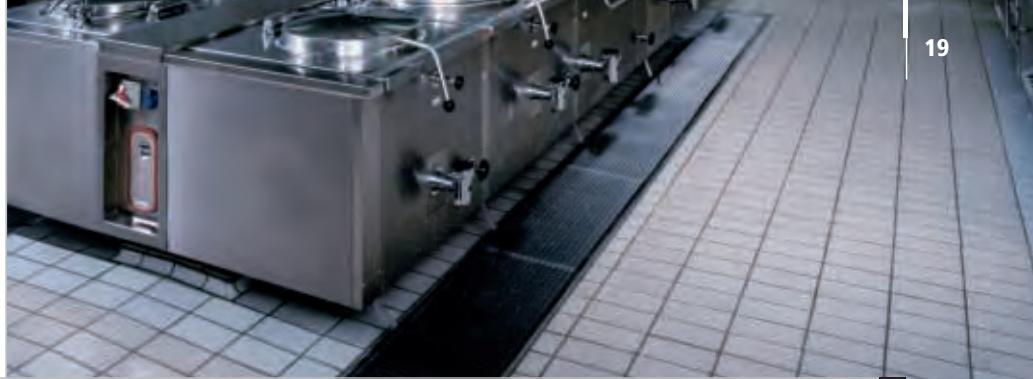
Abb. 15: Kombinationsbelag in einer Großküche
