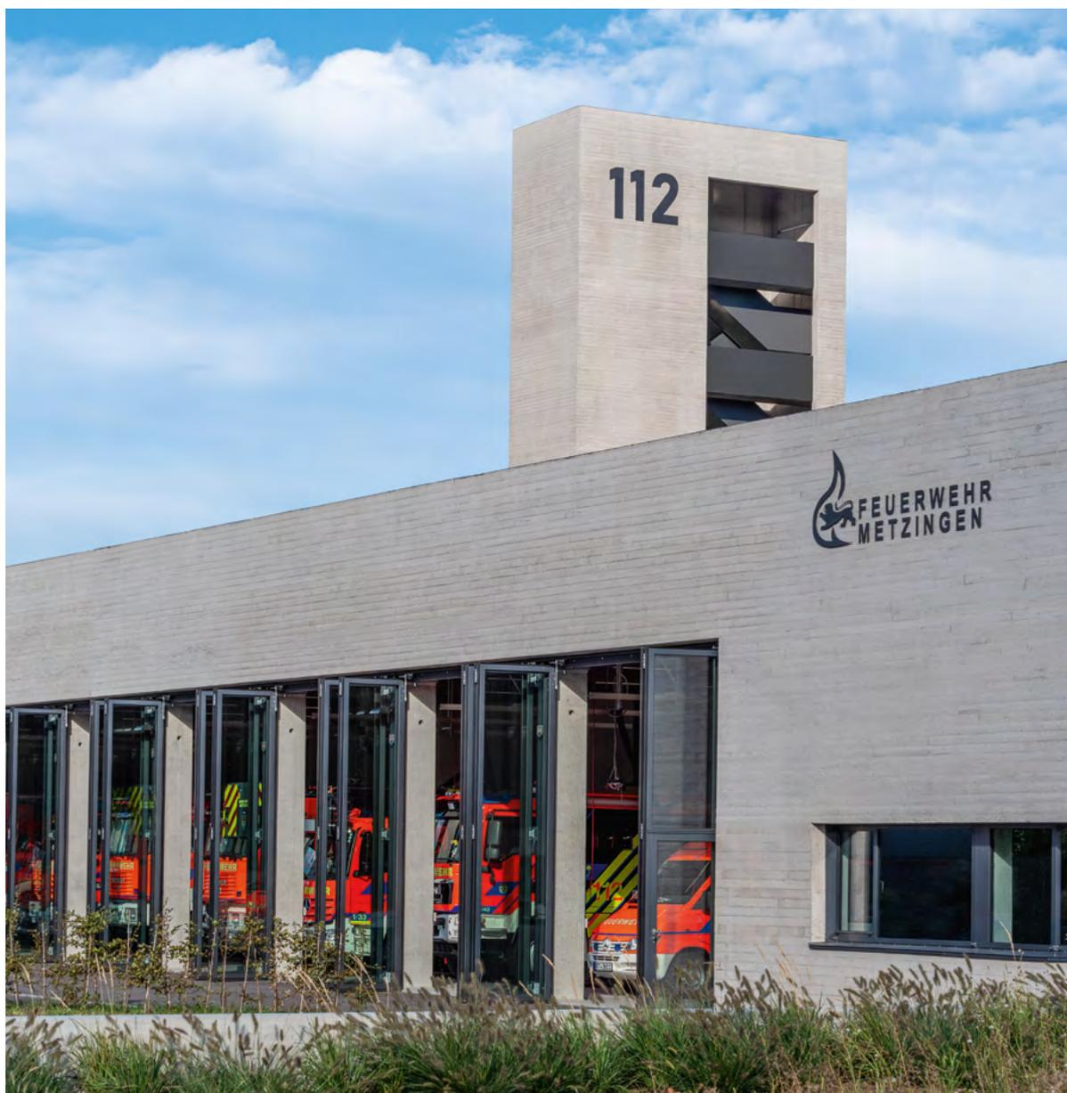
Feuerwache Metzingen: Der erforderliche Wärmeschutz gelingt durch den Einsatz von Leichtbeton.
